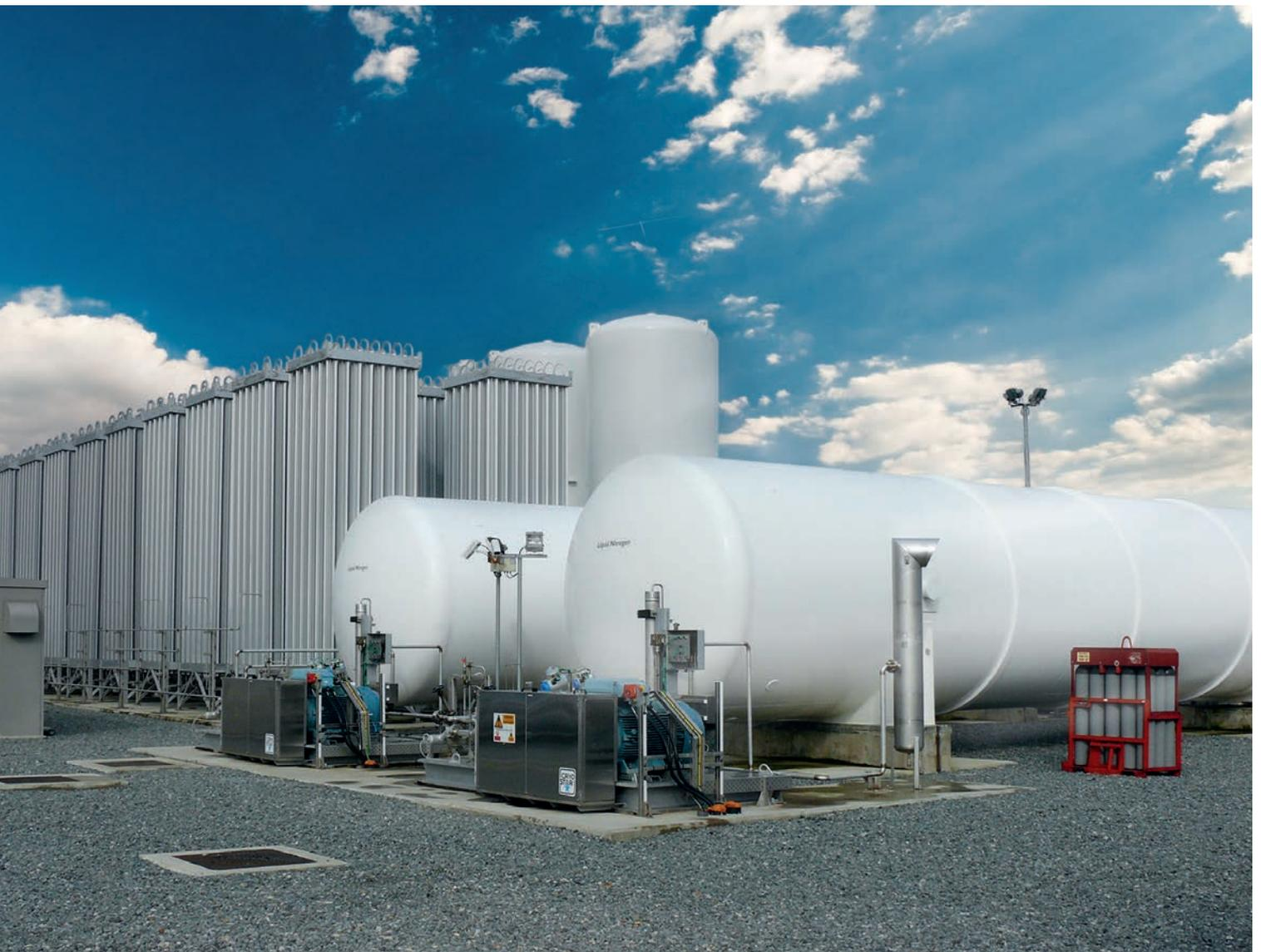
Die Gasmischanlage in Easington an der britischen Ostküste sorgt mit Hilfe von Stickstoff für die richtige Gaszusammensetzung. Ausgerüstet mit HEROSE-Armaturen für die Tieftemperaturtechnik
